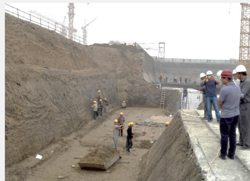
实创大厦基坑勘探
