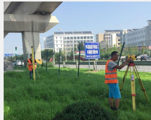
昌平区高架桥变形监测
