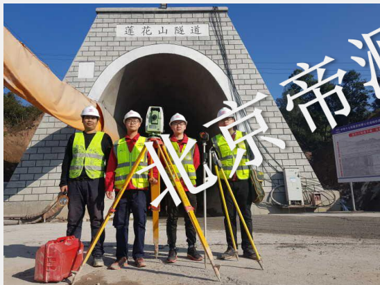
闽粤梅浦铁路施工监测
