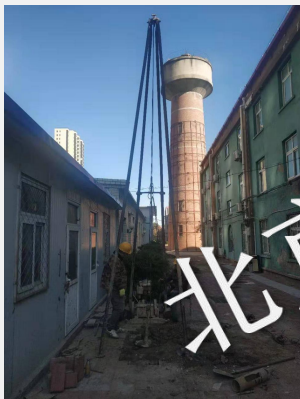
北京科技大学管庄校区 配电室勘察项目
