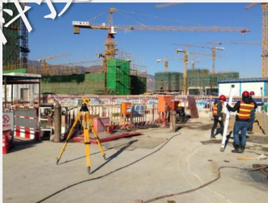
北京市地铁工程测量
